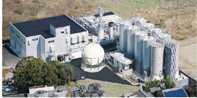
รูป 8.2.3 ตัวอย่างการผลิตก๊าซมีเทนชีวภาพขนาดใหญ่จากของเสียที่เป็นอาหาร (Distilled spirit processing waste recycling plant, Kirishima Shuzo co.LTD)
