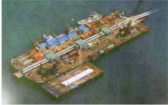
海底パイプライン敷設工法 (提供: JFEエンジニアリング)
