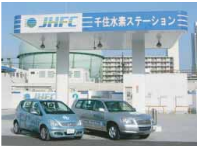
天然ガスオンサイト水素ステーション（提供：東京ガス）
