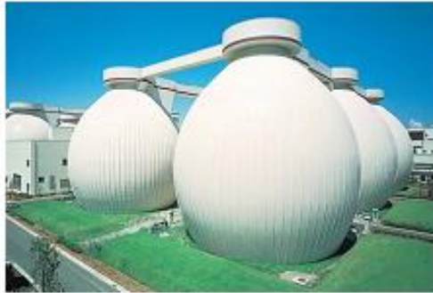
Gambar 8.2.2. Contoh digester anaerobik lumpur limbah skala besar.
