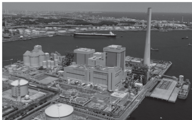
J-POWER（電源開発株式会社）磯子火力発電所
